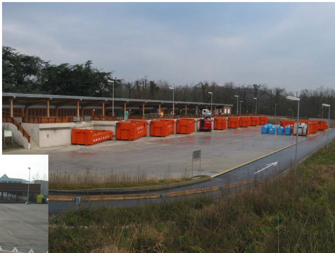
Espace récupération des Chânets (2005)
